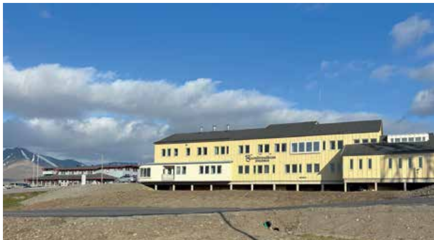
Najsjevernija bolnica nije sagrađena na čvrstim temeljima. Zapravo uopće nema temelja. Na stupovima je. Učili su nas da postoji paviljonski, koridorski i satelitski tip bolnica. E pa ovo je jedinstvena bolnica sojeničkog tipa.
