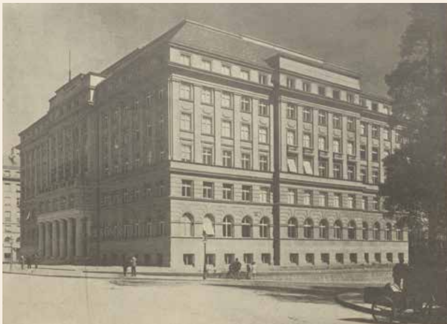
Zgrada Središnjeg ureda za osigu ranje radnika u kojoj je od otvorenja 1928. djelovalo Javno kupalište i zavod za fizikalno liječenje "Therapia"
